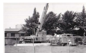
鉄筋園舎への建て替え工事の様子
