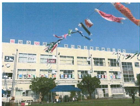
青空に泳ぐこいのぼりと屋上の表示
