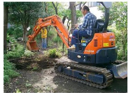
▼当時の造成の様子。重機で耕した土の中から、ネザサと呼ばれる植物や、石を取り除き、ビオトープの土台となるよう形を整え、ビニールシートを敷き込んだ。
